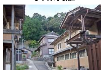
西山工場(丹後最古のちりめん工場)
