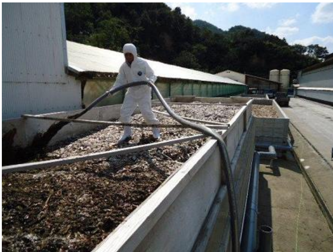
完成した 2 基の脱臭装置（縦×横×高さ：14m×3.2m×1.6m）に種菌を投入
