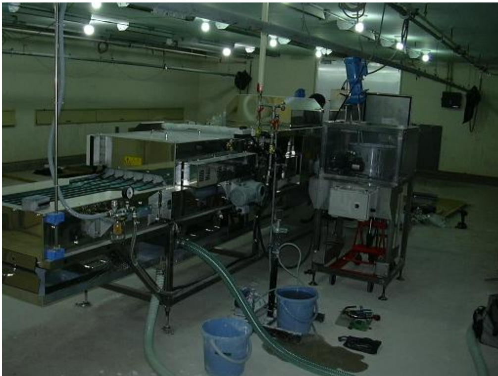
改修中の試作装置（鶏卵洗浄消毒装置）
