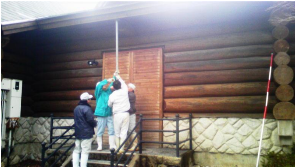
軒下に補強支柱を立てる（まきばホール）
