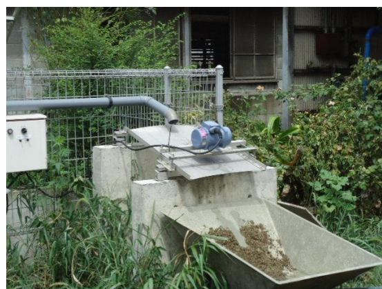
振動ふるい装置でパーラー排水から固形物を分離
