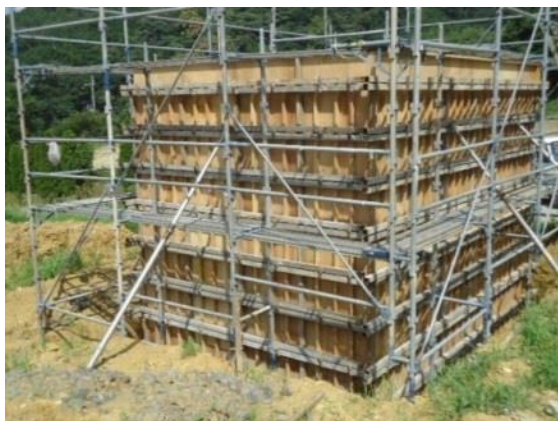
建設中の汚水処理施設の水槽
