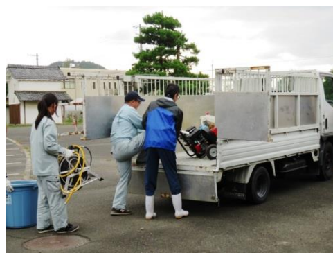
資材の積み込み
