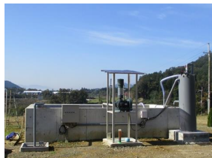
酪農家の污水处理施設
