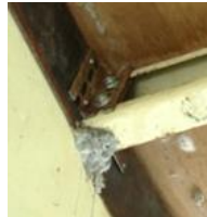
隙間を埋める(1晩で硬化)
