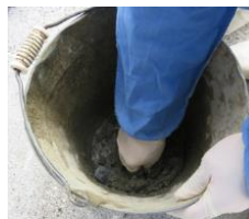
モルタルと水を加え混ぜ練る
