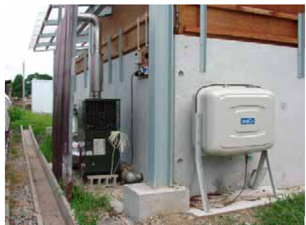
写真2：施設裏側にある温風送風装置
