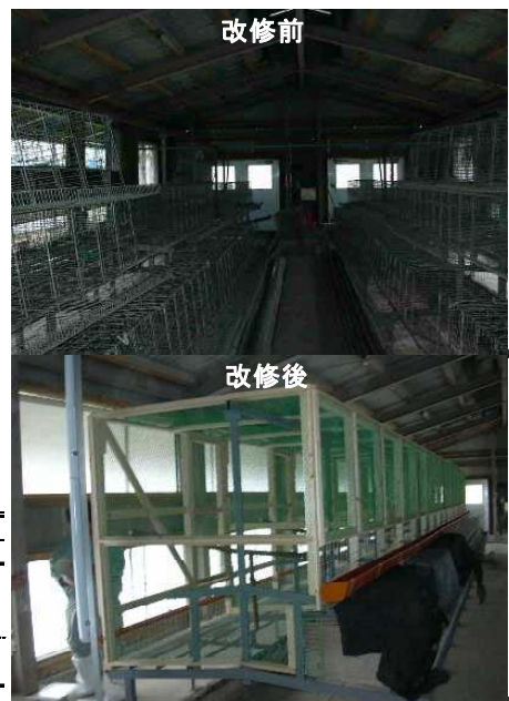
写真 鶏舎の改修事例
