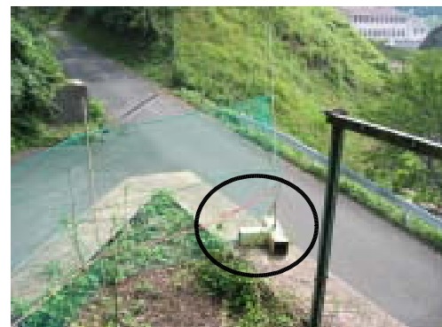
写真3 コンクリート擁壁上に設置した移動式電牧支柱立て
