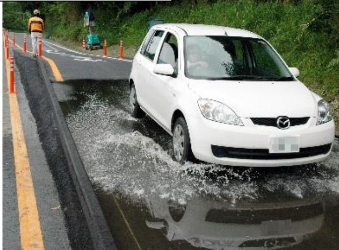
臨時車両踏込消毒槽
