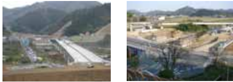
国道175号大川橋
