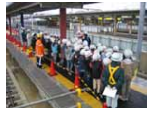
KTR高架工事見学会 (H20.12.5)
