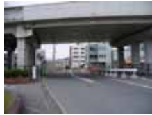
福知山駅付近連続立体交差事業
