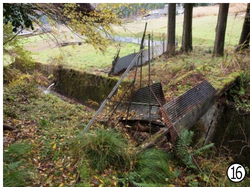
⑯弓削道登り口。集落の奥の谷川に古い木橋がかかっており、そこから尾根にとりつく。橋は老朽化している。
