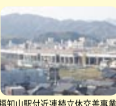
福知山駅付近連続立体交差事業（福知山市）
