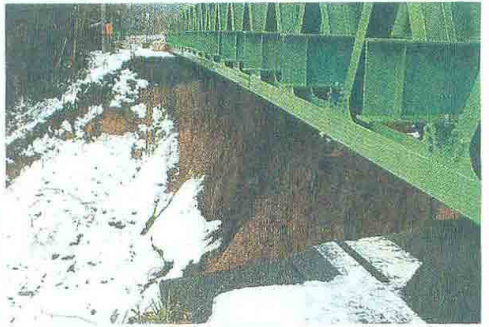
道路が崩落したままの国道173号。復旧の見通しはまだ立たない(綾部市寺町)
