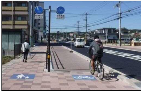
府道生駒井手線他（三山木駅周辺）
