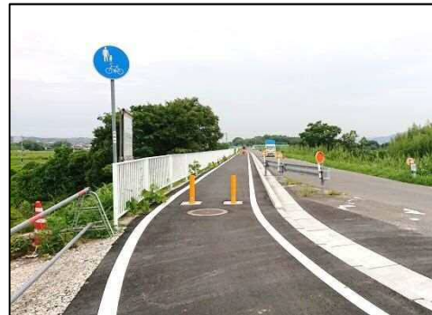
八幡木津自転車道線（木津川市）
