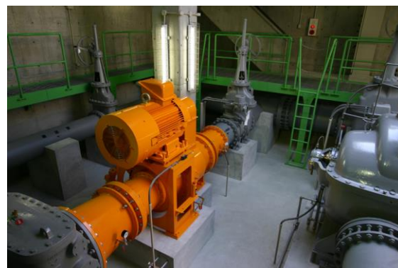
図3 久御山ポンプ場の小水力発電
