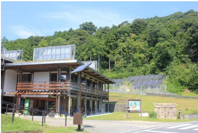
太陽光発電設備
