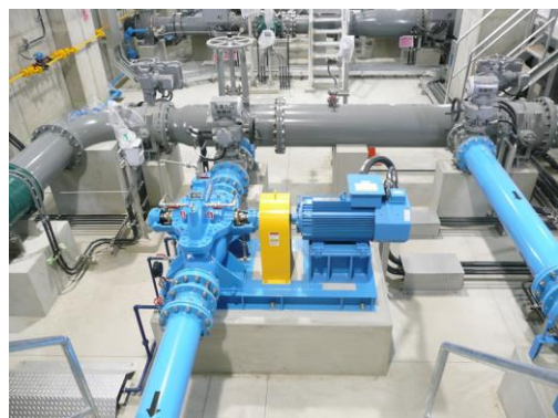
図2 宇治浄水場の小水力発電
