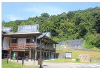
太陽光発電設備
