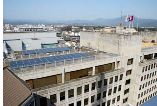
京都府庁 2号館屋上
