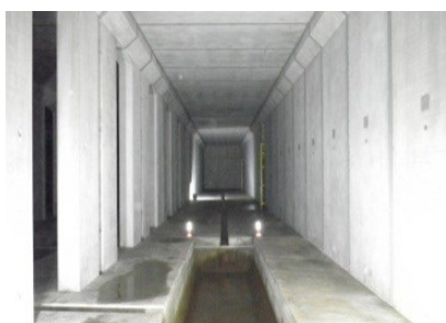
写真-1：貯留施設内部
