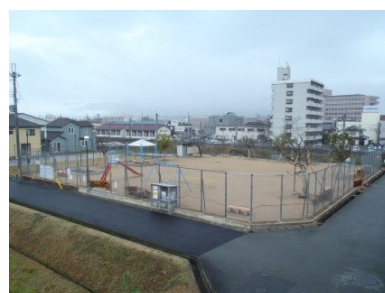
写真-3：公園リニューアル工事
