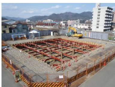
写真-2：工事の様子
