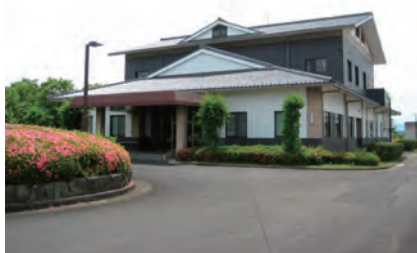
綾部市 綾部浄化センター
