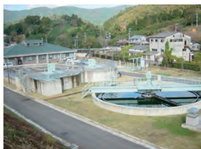
和束町 和束中央浄化センター
