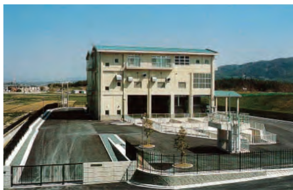
精華町 下狛ポンプ場
