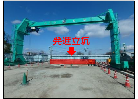
発進現場の状況 (H28.1月)
