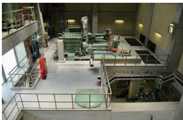
大山崎町 下植野排水ポンプ場内部
