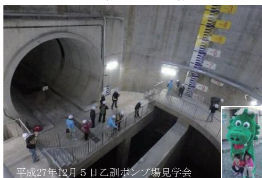
乙訓ポンプ場
