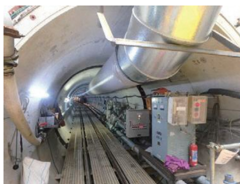
南幹線管渠シールド工事現場
