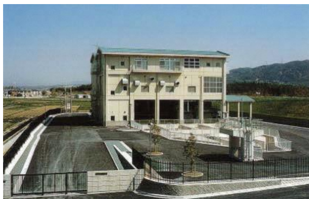
精華町 下狛ポンプ場
