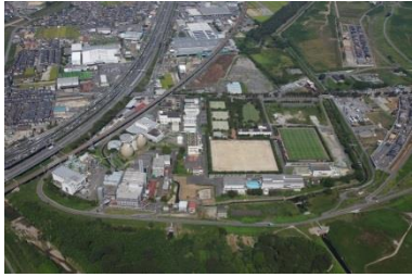
桂川右岸流域下水道 洛西浄化センター
