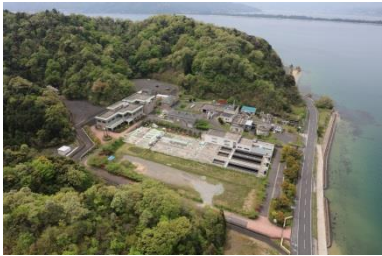
宮津湾流域下水道 宮津湾浄化センター
