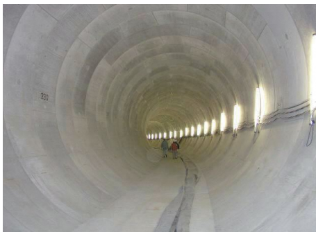
いろは呑龍（どんりゅう） トンネル北幹線第3号管渠
