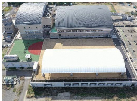
木津川上流浄化センター 交流広場・ふれあい広場
