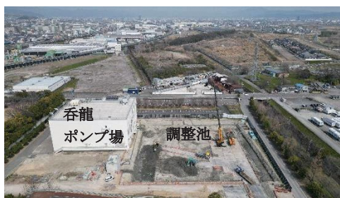
呑龍ポンプ場（調整池・ポンプ整備）工事（R5年3月時点）
