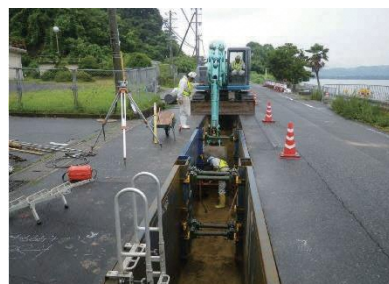
宮津湾流域 二条化工事
