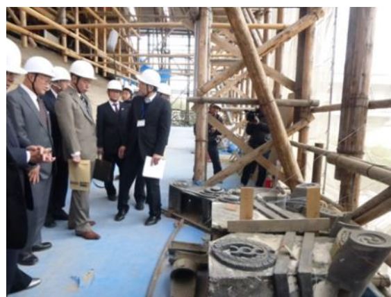
説明聴取後、修理現場を視察
