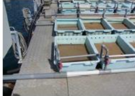
コンテナ、配管準備完了
