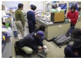
塩ビパイプの切り出し
