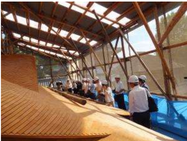
<飛雲閣のこけら葺きの修理状況を視察>
