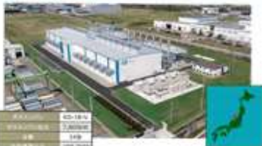
上越グリーンパワー発電所
