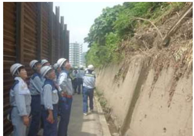
〈国道178号(宮津市日置)の崩落状況を調査〉
