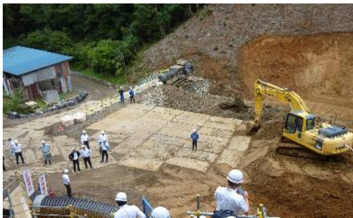
大島川の災害関連緊急砂防事業の進捗状況を視察
