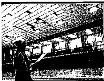
▲大山崎体育館の被害確認
