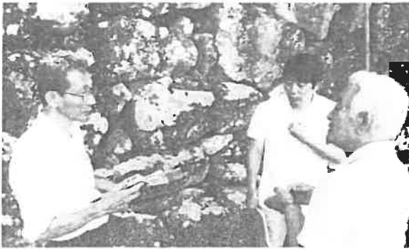
九州新幹線ルート諫早市のトンネル工事の影響を調査 (9月5日)
