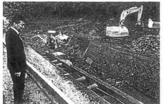
天倉川(高津町)の護岸工事
