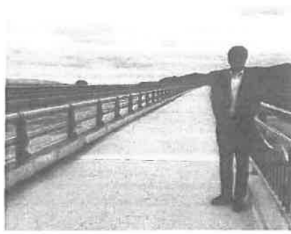
東中央線工事現場（木津 川市）
