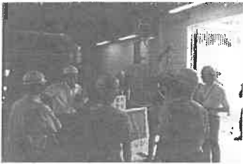
▲乙訓浄水場で場内設備についての説明を受ける様子
