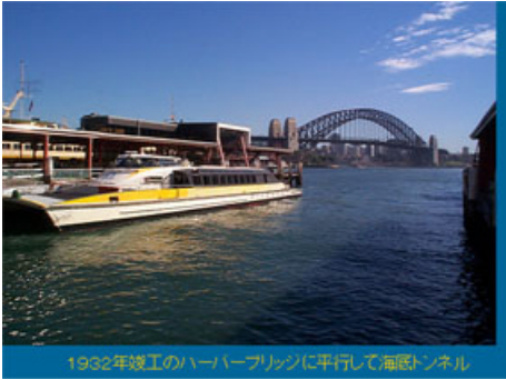
1932年竣工のハーバーブリッジに平行して海底トンネル
