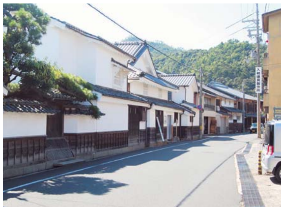
重要文化財旧三上家住宅
