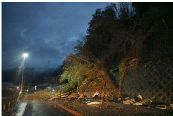
【写真-4 国道9号被災状況 (H31. 1)】
