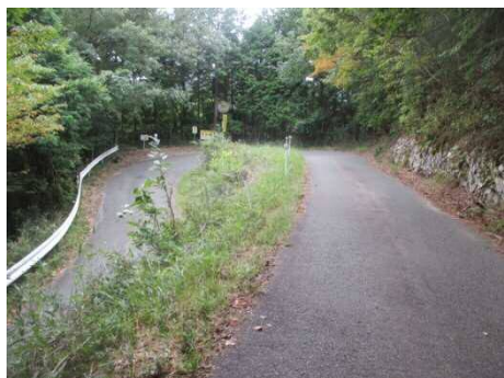
【写真-1 ヘアピンカーブ箇所】
