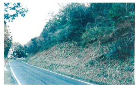
写真-1 整備前の状況
