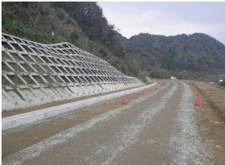
写真-3 施工直後の状況
