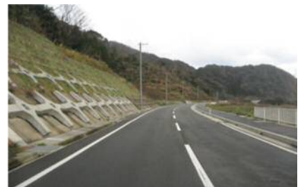
写真-2 整備後の状況
