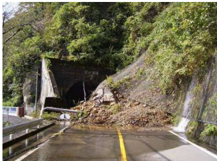
写真-F トンネル付近の土砂災害発生状況
