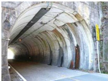
写真-A トンネルの状況
