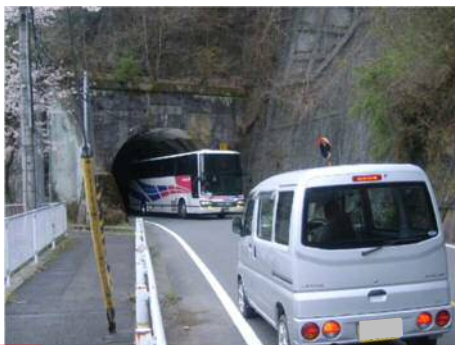
写真-D トンネルの通行状況
