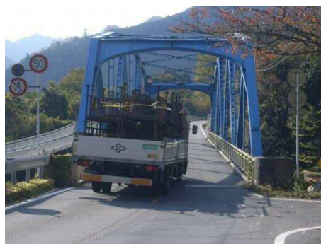
写真-E 音海橋の通行状況
