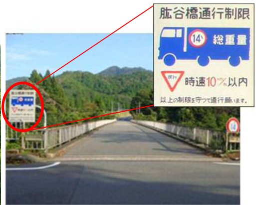
写真-L 肱谷橋通行制限
