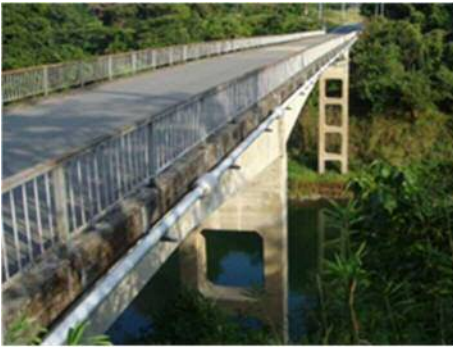
写真-J 肱谷橋の状況
