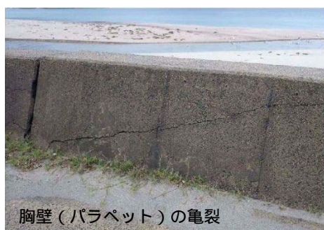
図1-3-6 護岸の老朽化
