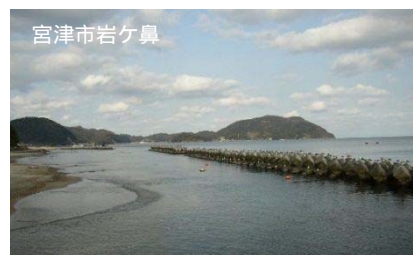
図1-5-4 整備された海岸保全施設
