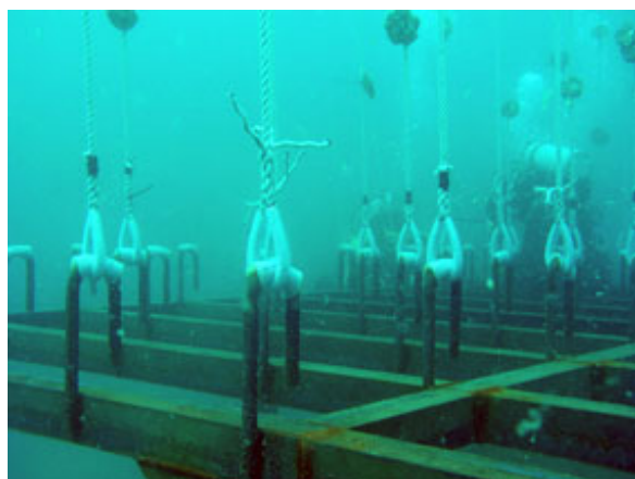
写真2 養殖ロープ取り付け用の魚礁上部のフック
