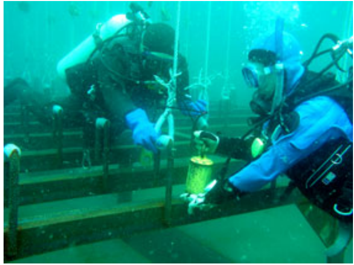
写真4 養殖ロープの取り付け作業 錘をつけて養殖ロープを沈め(左)、鋼製魚礁上部のフックに養殖ロープを取り付ける(右)
