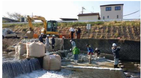
ふしのがわ ■扇形簡易粗石付き斜路式魚道（山口県榎野川）中央設置型
