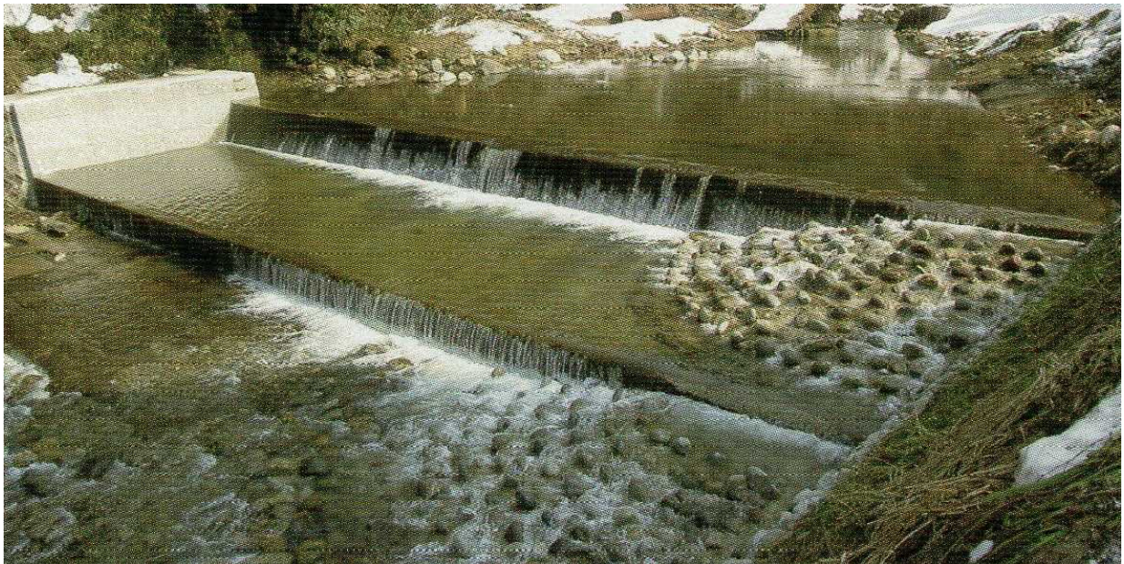
■扇形簡易粗石付き斜路式魚道（富山県熊野川）側面設置型
