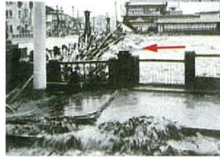
▲四条大橋付近の氾濫状況
