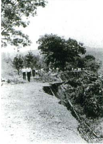
▼御園橋下流右岸側の被災状況
