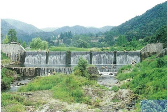
▲ 杉野堰堤 (ひいらぎのえんてい) 昭和10年の災害を機に上流からの土砂を抑制するために構築されました。
