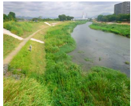
水とのふれあい回廊（京川橋上流）
