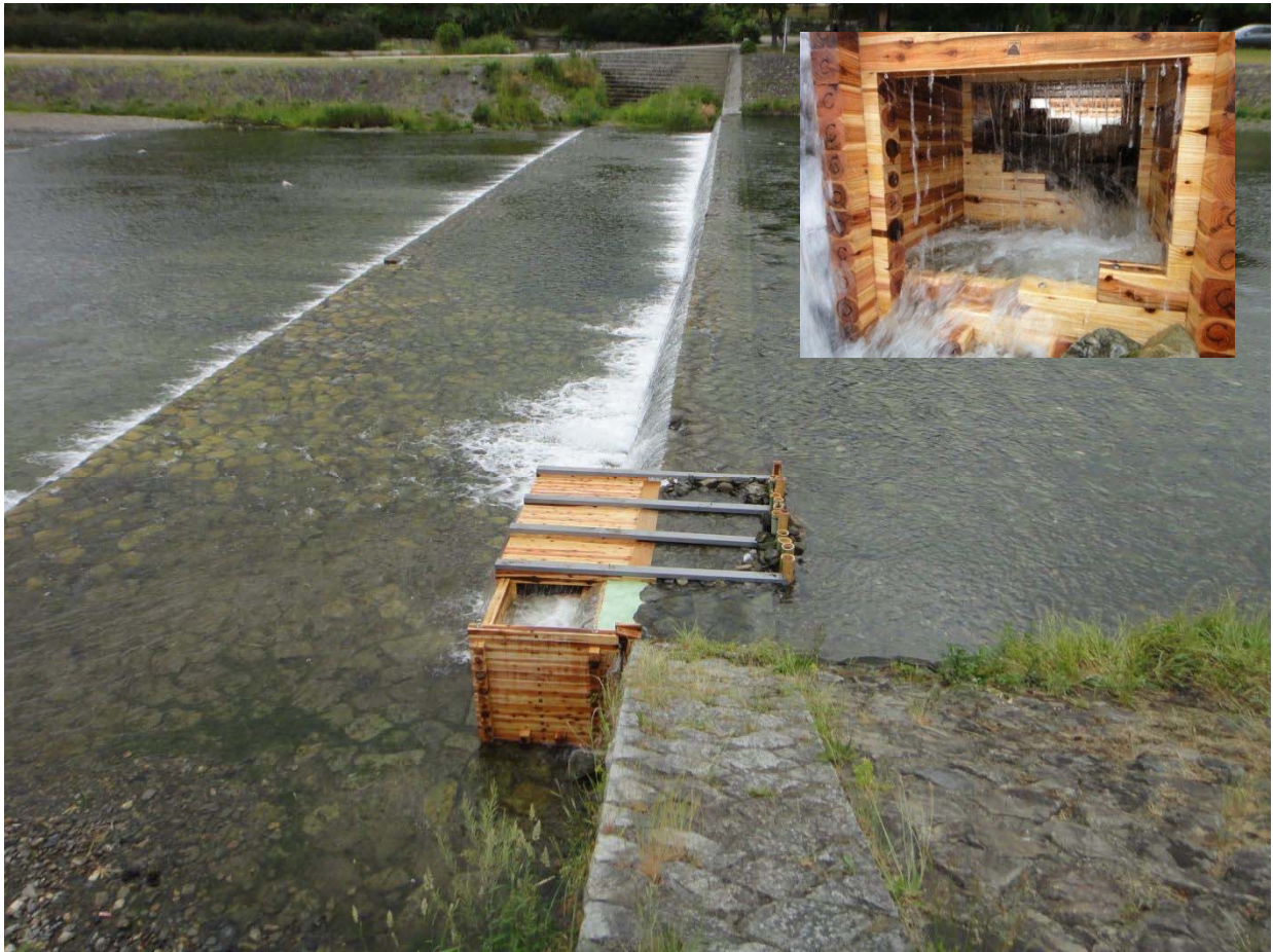
⑥ 荒神口落差工（右岸） 木組み斜路式魚道 新規設置
