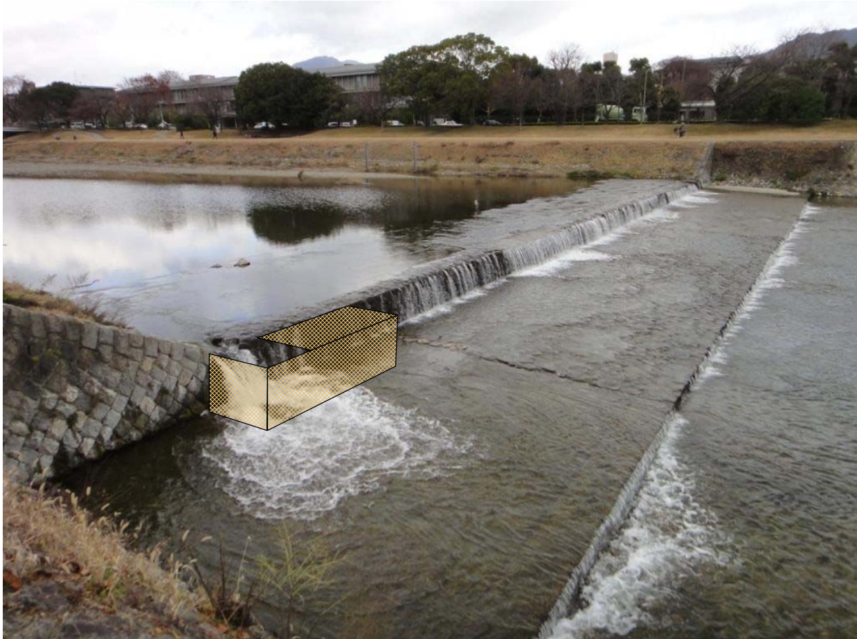
⑥ 荒神口落差工（右岸） 木組み斜路式魚道 新規設置
