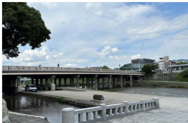
三条大橋右岸南側（昼間）
