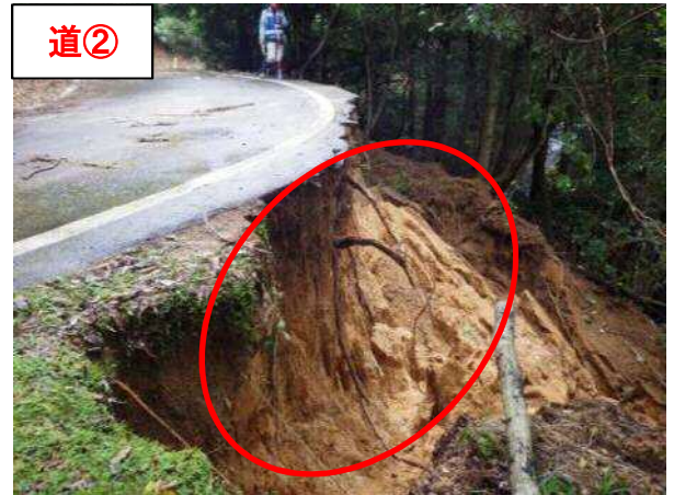
道② 【場 所】 よさのちょう なかふじかやせん 与謝野町 (一) 中藤加悦線 【被災状況】路肩欠壊 延長 20m (1 箇所 4 工区) 【復旧内容】大型ブロック 20,000 千円
