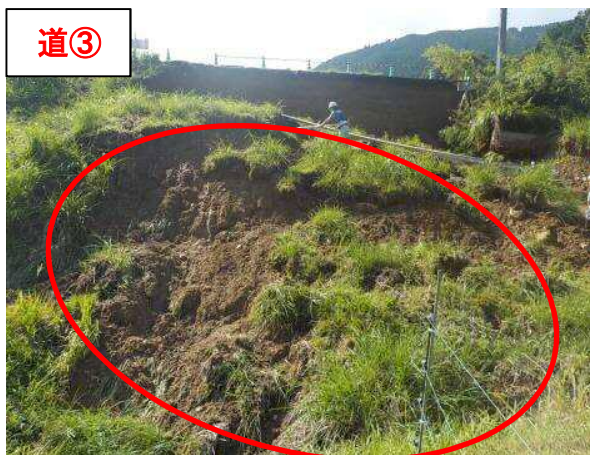
道③ 【場 所】 ふくちやまし しものじょうかみかわぐちいしやじょうせん 福知山市 (一) 下野条上川口停車場線 【被災状況】法面崩壊 延長 73m (3 箇所) 【復旧内容】吹付法柁 45,000 千円
