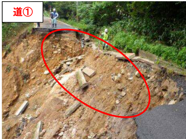
道① 【場 所】 きょうたんごし いねちょう 京丹後市・伊根町 (一) きゆうそいねせん 久僧伊根線 【被災状況】車道欠壊 延長 234m (7 箇所 7 工区) 【復旧内容】擁壁工・盛土 204,000 千円
