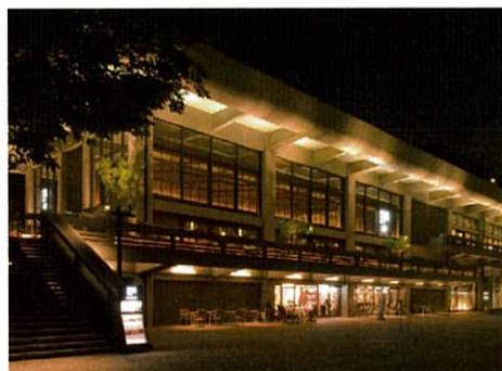
厚みのある庇が特徴の近代建築。投光器で照らすことで重厚さが印象的に、灯具は周囲から見えない位置に設置されている。
