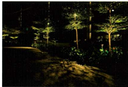
幹にスポットライトを設置して枝越しに地面を照らしている事例
