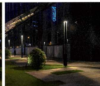
②カットオフ型のポール照明 上方向に光が出ないように設計された照明器具をカットオフ型といい、ポール照明に用いれば上空と周辺への余分な光を遮断し地面だけを照らすので環境にもやさしい。園路など広範囲を照らしたい場合に向いている。
