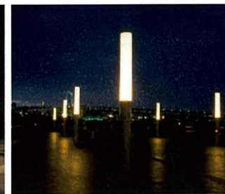
③発光型のポール照明 照度を確保するだけでなく、光るポール自体がアイキャッチになる。生活の中のあたりとは異なり、都市のインフラとして整備される。明る過ぎるものは発光部分の輝度が強くてグレアになるため、適度な明るさのものを選ぶとよい。
