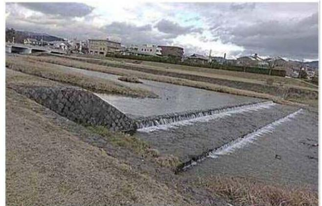
曲線と石積・石張で構成された床止堰堤
